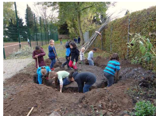
Ausheben des Grabens
